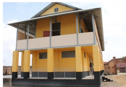
Case d'entrée droite du Camp de la Transportation (après rénovation)
